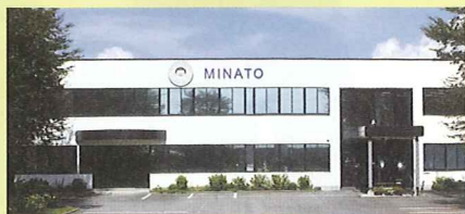
栃木県那須塩原市にある 那須工場。
